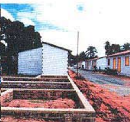
Construção de casas populares
