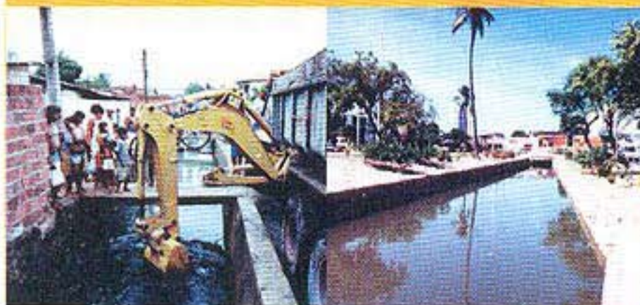
Limpeza de canais
