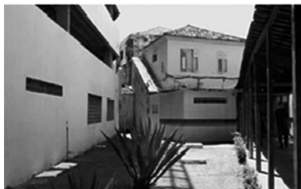
Edificação com faixa de azulejos, ao centro, dificulta o acesso ao prédio original do DOI-CODI do IV Exército, local apontado como de prática de tortura. Fonte: Arquivo CNV. Relatório CNV - Vol. I, p. 786.
