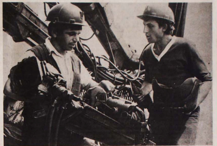
Operários albaneses constroem a hidrelétrica de Koman, no rio Drin, com 600 mil kw de potência. Hoje Koman é a ponta de lança da edificação econômica do socialismo. No Plano Quinquenal passado, este papel coube ao complexo siderúrgico "Aço do Partido", em Elbasan, um moderno pólo industrial hoje em plena produção.
