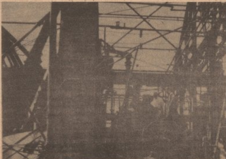
Aquí se ve 'Ware Chemical' luego de las explosiones.
