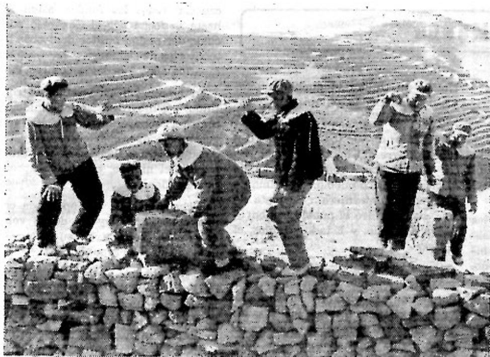
Cuadros y miembros de la brigada Nannao trabajan juntos para construir una terraza.
