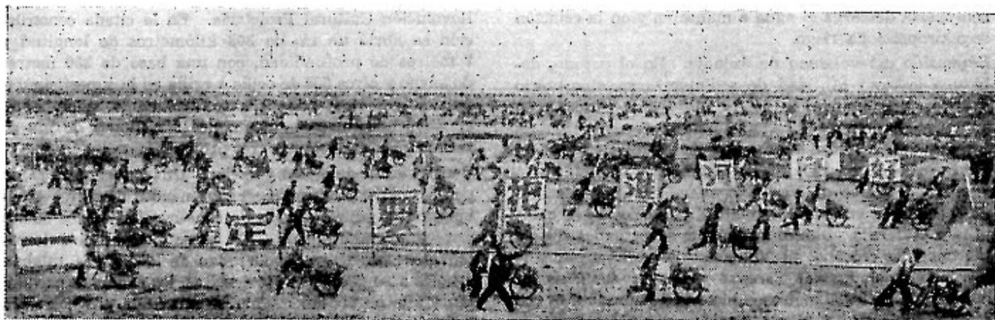
Obra en construcción.
